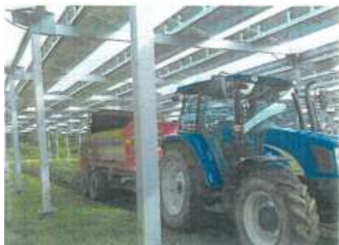
大型機械も作業可能
