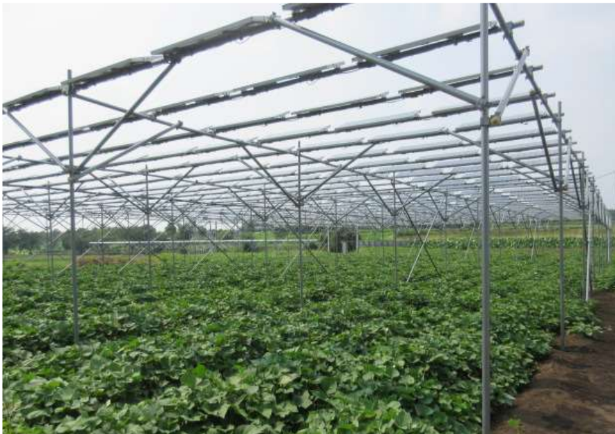
露地の畑の上部にパネルを設置
