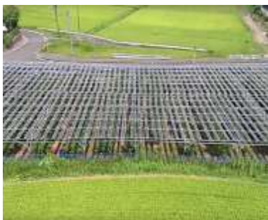
発電施設の外観
