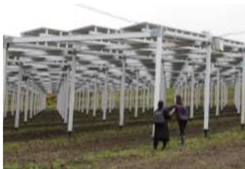
支柱高3.5m、間口6mで設計
