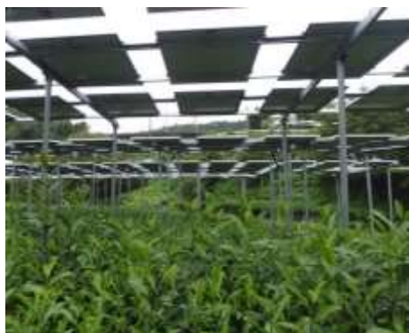
設置された太陽光パネル
