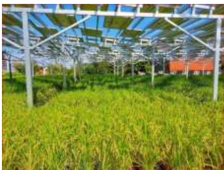
地区②の発電設備の外観
