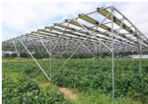
発電設備の外観
