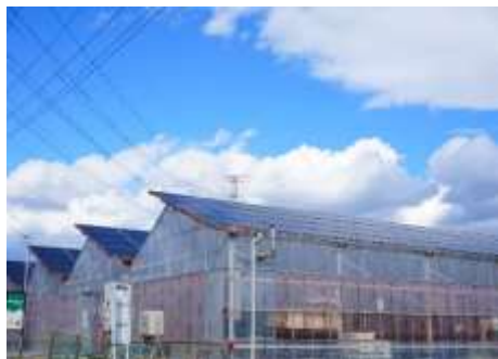
発電施設の外観
