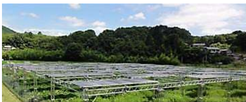
発電施設の外観
