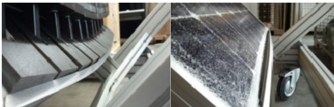
ブロックによる sin 加力 破壊時の状態（終局耐力と規定される） 図 A.3-2 sin 荷重による破壊例（出典 TUV ラインランド）
